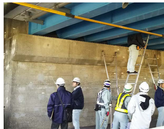
▲橋梁点検状況
