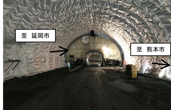
しんひらそこ 新平底トンネル 進捗状況
