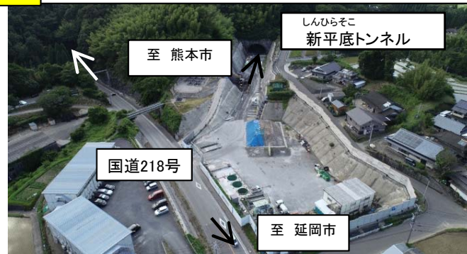
ひらそこ 平底交差点付近 進捗状況
