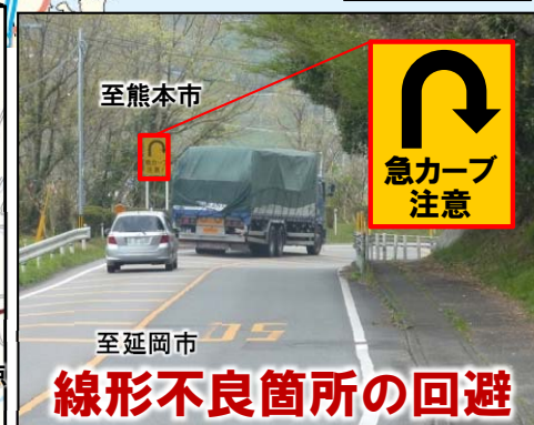
▲ 線形不良箇所(R=60)写真
