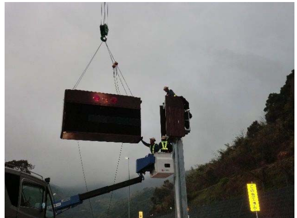
<情報板設置工事>
