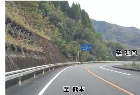
▲現道線形不良箇所(写真②)
