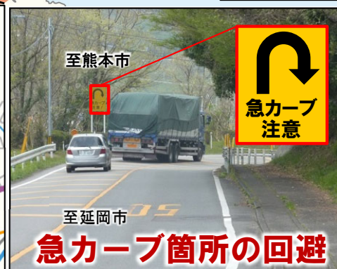
▲ 急カーブ箇所(R=60)写真
