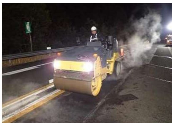
＜舗装補修工事＞
