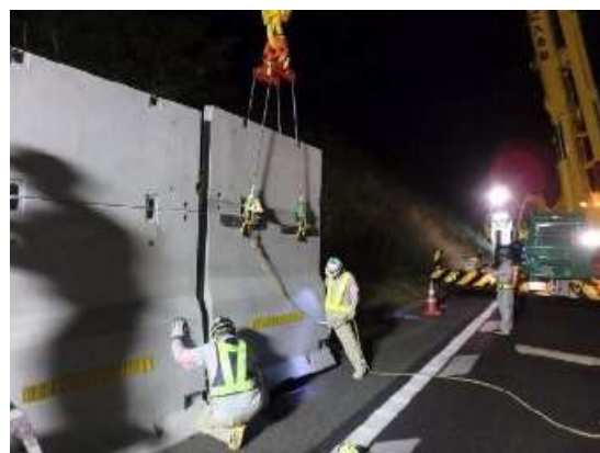
＜仮設落石防護柵撤去・設置＞
