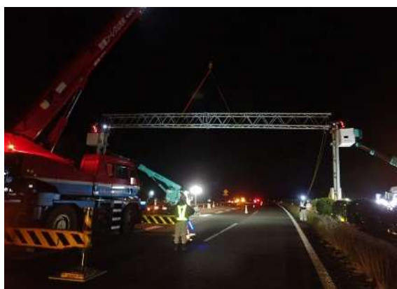
＜門型標識柱撤去・設置作業＞
