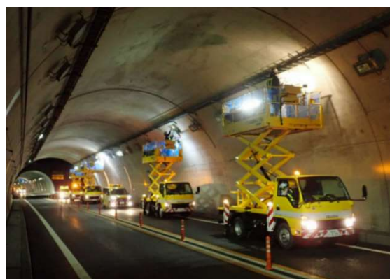
＜トンネル内照明設備点検＞
