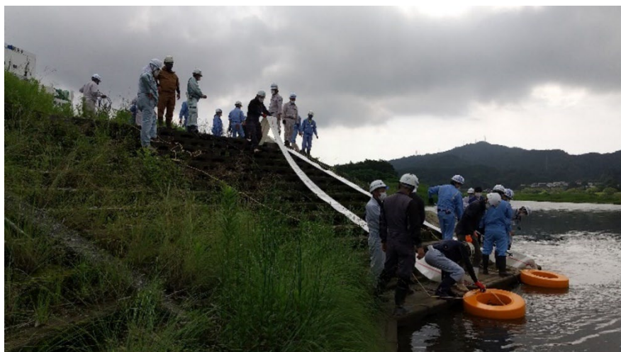
ポンプ設置状況
