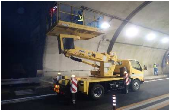
＜トンネル照明内機交換作業＞
