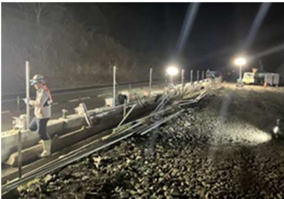
＜仮設防護柵工＞
