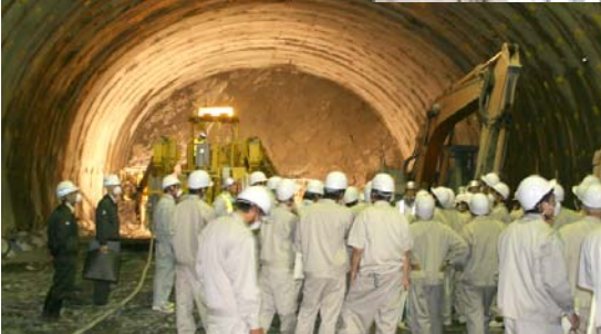
▲古江トンネル南新設工事トンネル内
