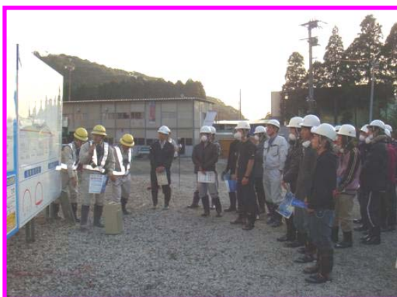
▲陣が峰トンネル工事概要の説明
