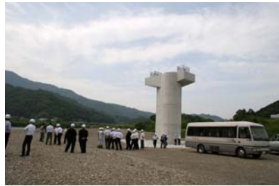
▲延岡道路 北川第二橋 見学状況
