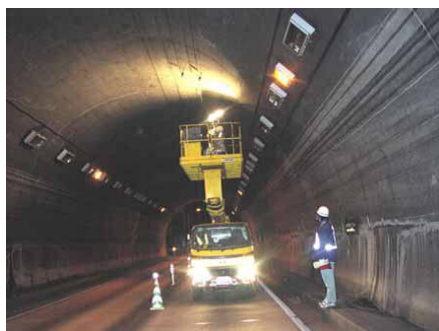
【高所作業車による点検】
