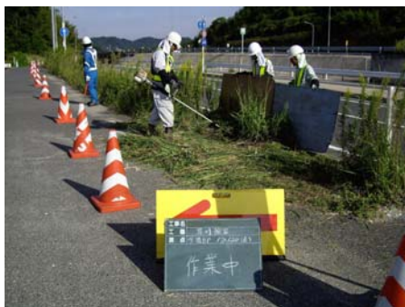
【除草作業状況】
