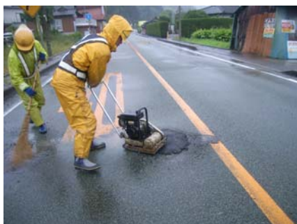
【補修作業状況】
