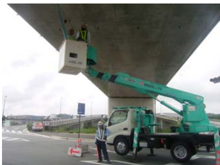
【高所作業車による点検】
