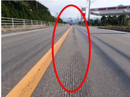
【補修後（凹凸削り取り）】
