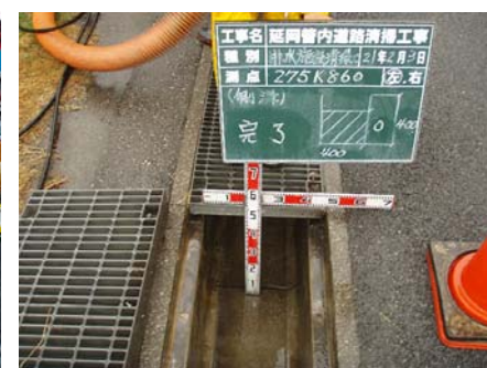
【清掃後の側溝の状況】
