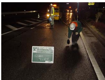
【補修作業（補修材注入）】
