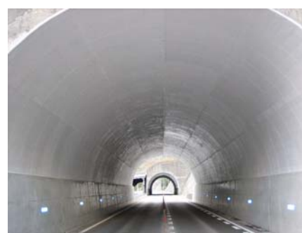
【補修後（炭素繊維補強）】
