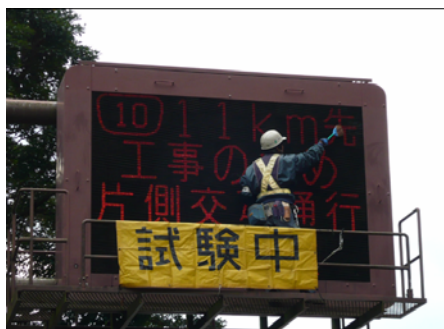
【道路情報板点検状況】
