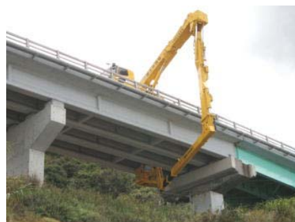
【橋梁点検車による点検】
