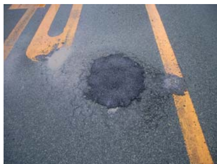
【補修後（穴埋め）】
