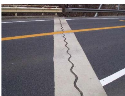
【補修後（橋の伸縮装置の取替）】
