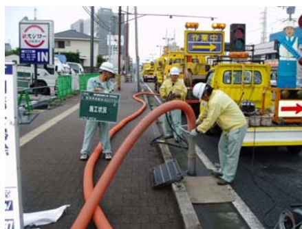
【側溝の清掃状況】
