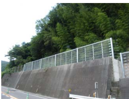
【対策後（落石防護柵）】
