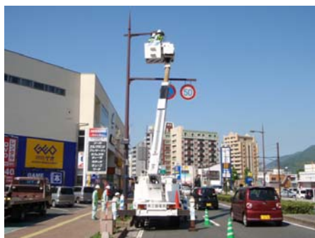
【道路照明灯ランプ交換状況】
