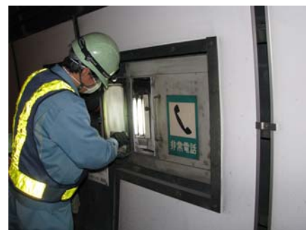
【トンネル非常用施設 （非常用電話）点検状況】
