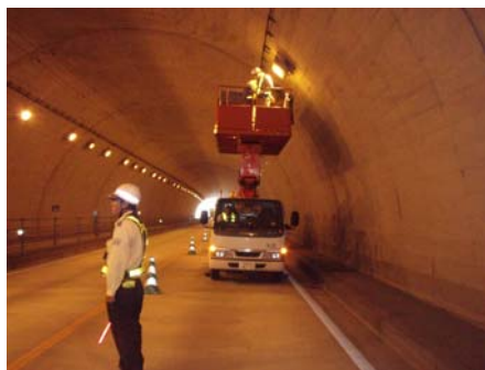
【トンネル照明ランプ交換状況】
