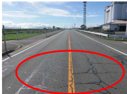
【補修後（ひび割れ注入）】
