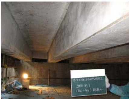
【補修後（コンクリート断面の修復）】
