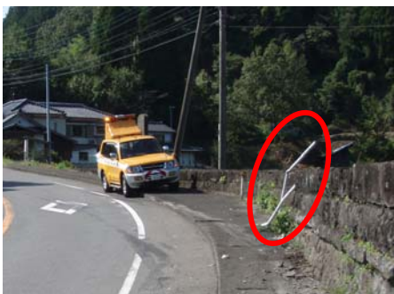
【道路標識の異状発見】
