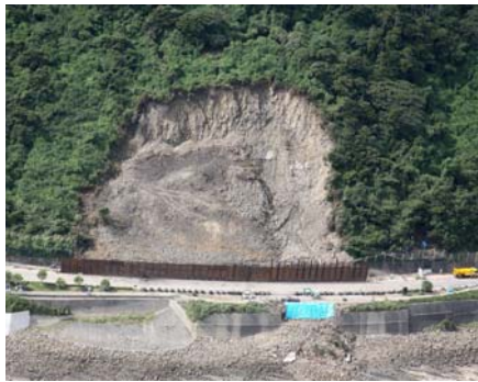
【応急復旧状況】
