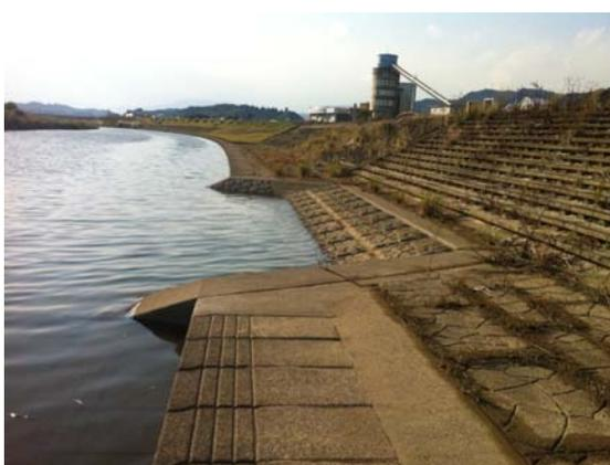
図 3.6-8 拠点对岸の護岸（船着場が整備されている）
