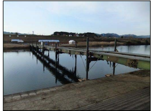
81式自走架柱橋
