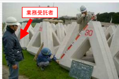
(根固めブロックの材料確認)
