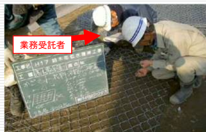
(河川護岸用かごマットの材料確認)
