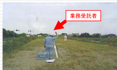
(現場状況の照合を実施)
