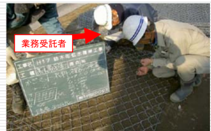
(河川護岸用かごマットの材料確認)
