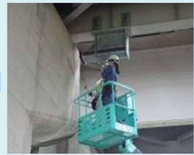
8/6現場視察（府内大橋）橋梁点検
