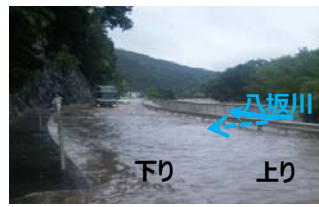
▲路面冠水での通行止め状況 (H24.7.3)
