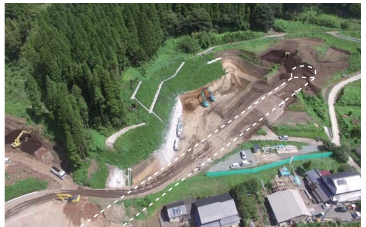
滝室坂道路 トンネル坑口(熊本側)
