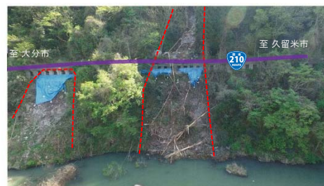
▲H28.4熊本地震による崩壊状況
