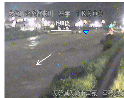
【小畑橋下流(R2.7出水時)】
