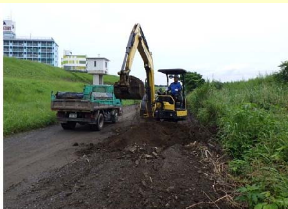
河川敷道路の土砂撤去（大分川広瀬橋上流左岸等）
