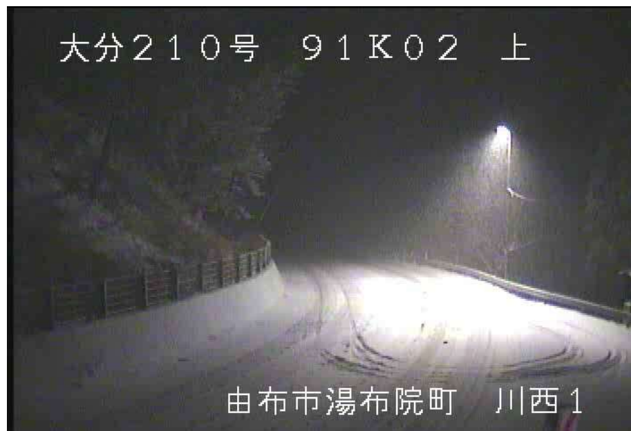
国道210号 由布市湯布院町川西
