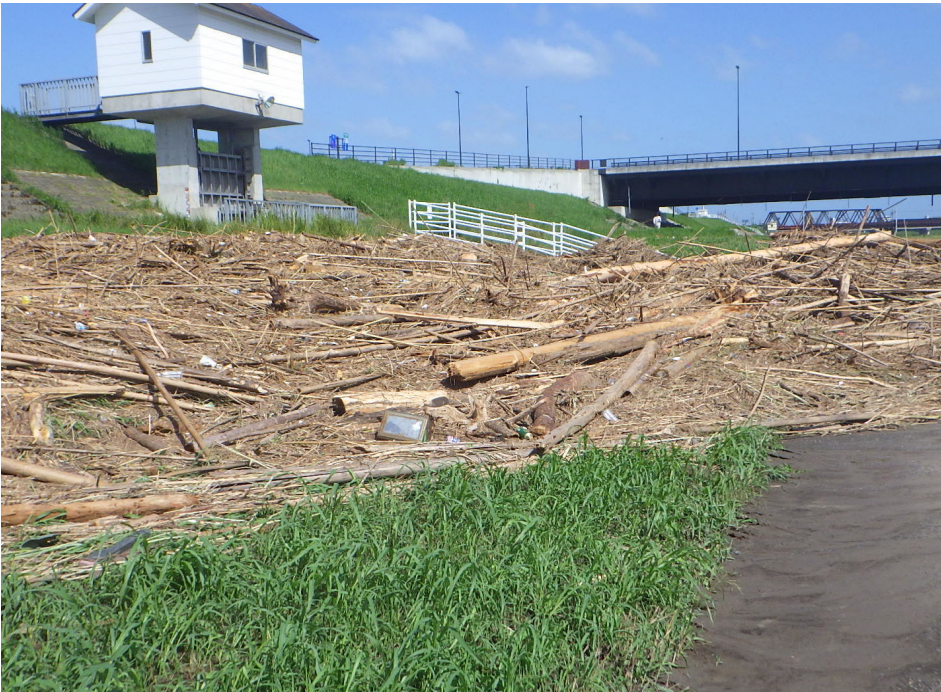
大分川(宗麟大橋上流左岸)
