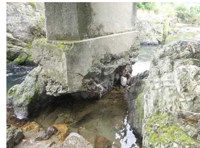
地方自治体管理 橋脚洗掘
