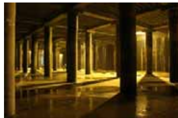
大規模地下貯留施設(下水道)
