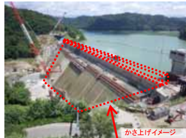
ダム建設・ダム再生
