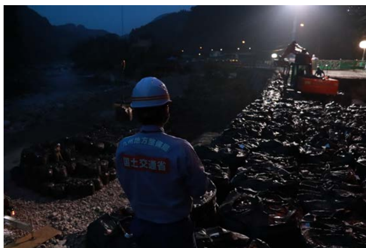
夜間施工の監督
