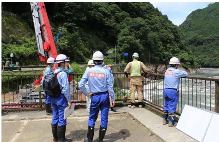
河川内での施工状況の確認
