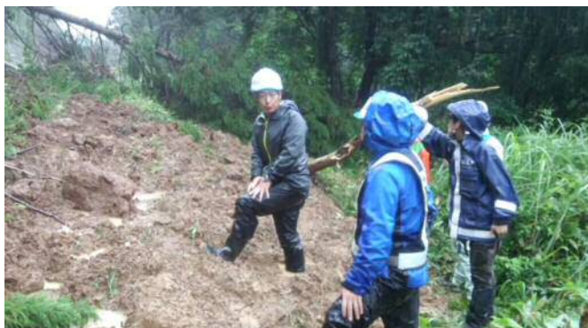
法面崩壊現場の状況を確認
