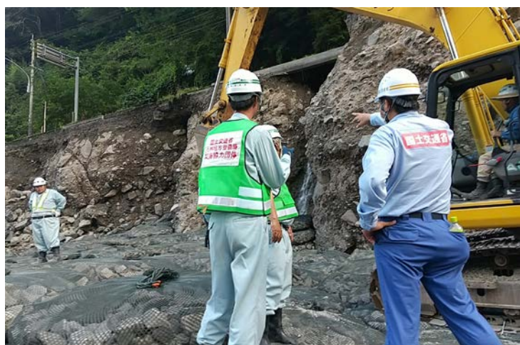
安全施工について指示
