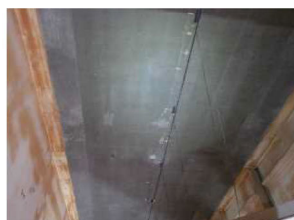
光ファイバセンサーによる 橋梁モニタリング
