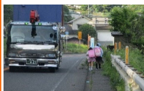
国道210号野上東歩道整備
