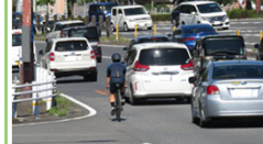
国道10号西大分自転車通行空間整備
