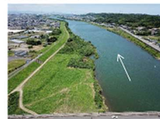
【整備前】(樹木伐採・土砂撤去)
