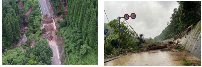
法面崩壊(九重町野上)
