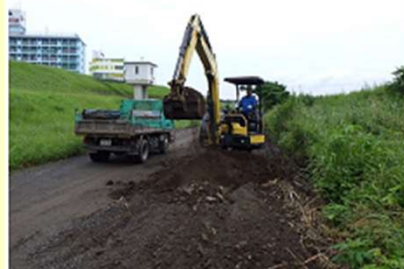
河川敷道路の土砂撤去(大分川広瀬橋上流左岸等)
