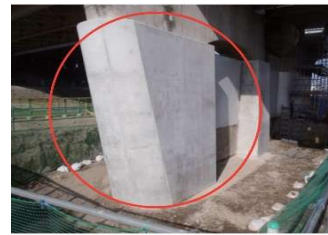
【橋脚の耐震補強対策】(コンクリート巻立て)
