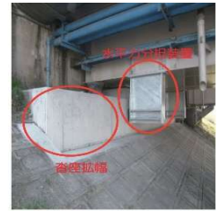
【橋脚桁の落橋防止対策】(水平力分担装置の設置や沓座拡幅)
