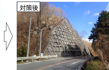
【法面防護対策】コンクリート法枠
