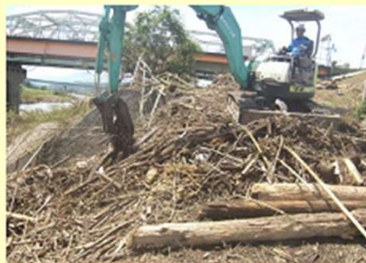
流木等の撤去(大分川明礪橋下流左岸等)
