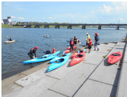
▲令和5年に完成した親水護岸。水辺アクティビティの拠点として活用されている(舞鶴地区)
