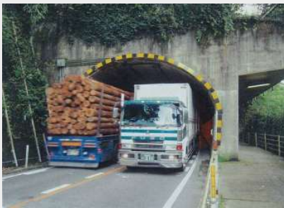
【現況のトンネル状況】
