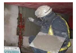
補修等の計画に基づき、効率的に補修等を行う。
