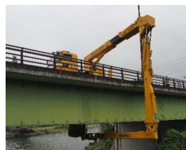
定期的な点検し、損傷状況を把握。
