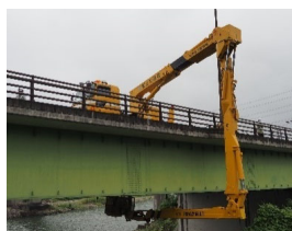
定期的な点検し、損傷状況を把握。
