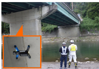
点検支援技術を活用した点検
