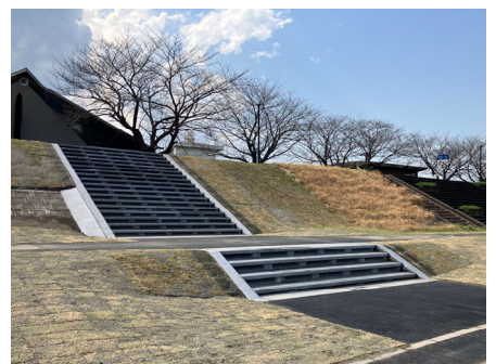
▲ 川裏のカヌー艇庫前から親水護岸への動線を考慮し階段を整備(舞鶴地区)
