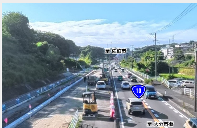
工事状況 R8.6
