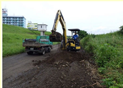
河川敷道路の土砂撤去 (大分川広瀬橋上流左岸等)
