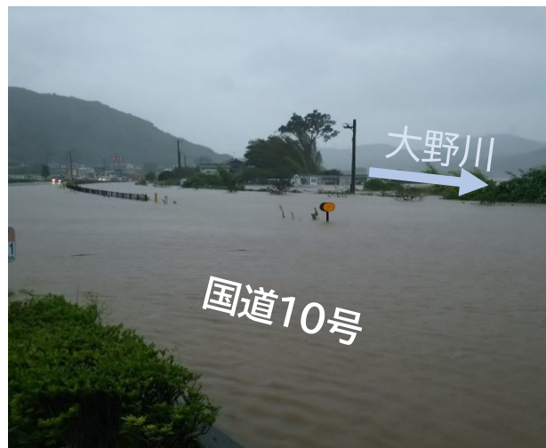
大野川右岸利光地区浸水状況 (H29.9.17)
