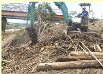
流木等の撤去 (大分川明礪橋下流左岸等)
