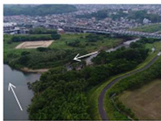
【整備前】(樹木伐採)
