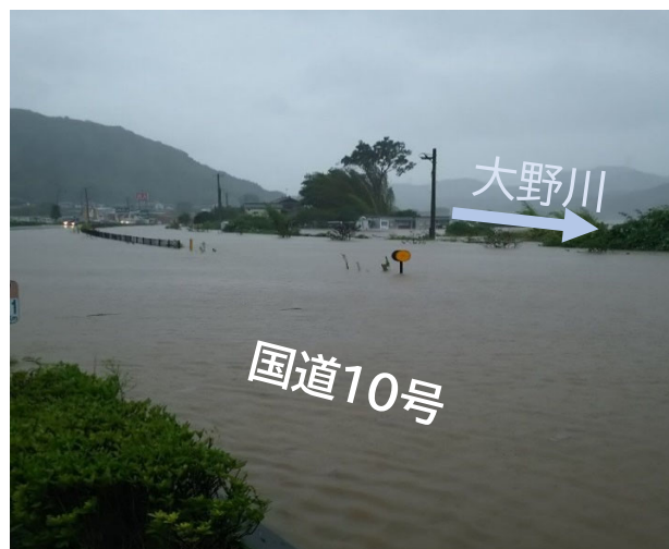
大野川右岸利光地区浸水状況 (H29.9.17)
