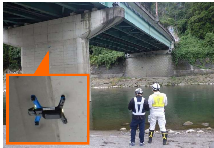
点検支援技術を活用した点検
