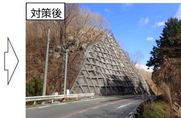
【法面防護対策】コンクリート法枠
