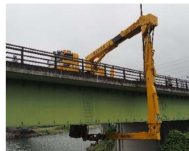
定期的な点検し、損傷状況を把握。
