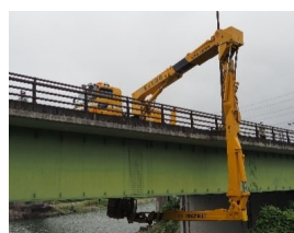
定期的な点検し、損傷状況を把握。
