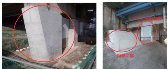
【橋脚の耐震補強対策】 (コンクリート巻立て)
