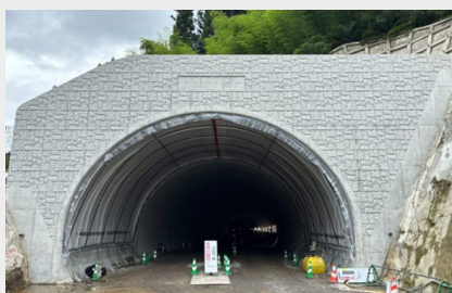
久留米市側 坑口
