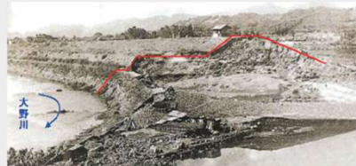
大分市大津留地区 (大野川8k400付近)
