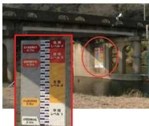
避難の基準となる水位など危険度レベルを示した水位表示板を橋脚等に設置し、川の水位をわかりやすくお知らせします。
