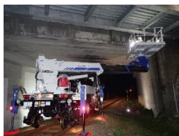
跨線橋の点検
