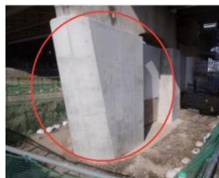
【橋脚の耐震補強対策】 (コンクリート巻立て)
