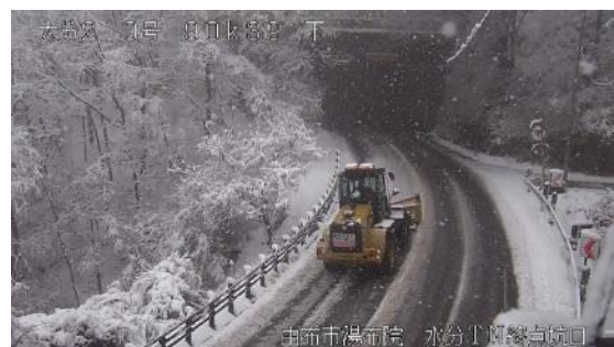
国道210号の雪寒対策(除雪作業)
