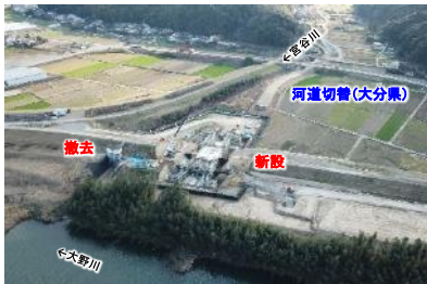
【工事状況 R2. 2】
