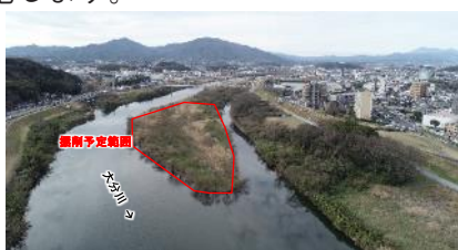
【現況 R2.2】(古国府地区)
