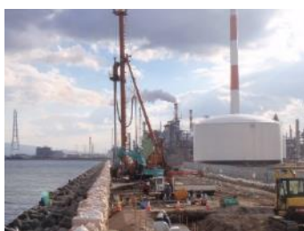
【工事状況 H25】
