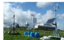
簡易型河川監視カメラ （現場実証の状況）
