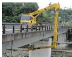
定期的な点検し、損傷状況を把握。
