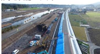
【工事状況 R2.2】
