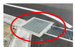
道路上の排水施設
