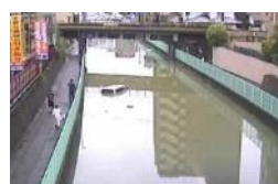
道路の冠水状況
