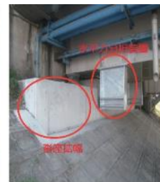
【橋脚の落橋防止対策】 (水平力分担装置の設置や資産拡張)
