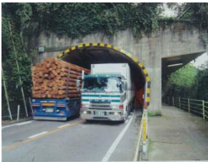
【既設トンネルの状況】
