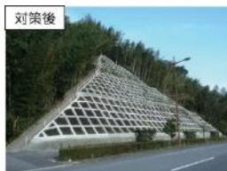
【法面防護対策】コンクリート法枠
