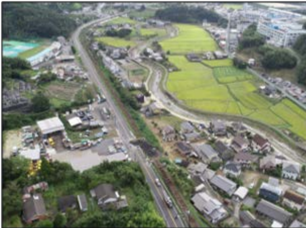
国道10号中判田地区【被災直後】
