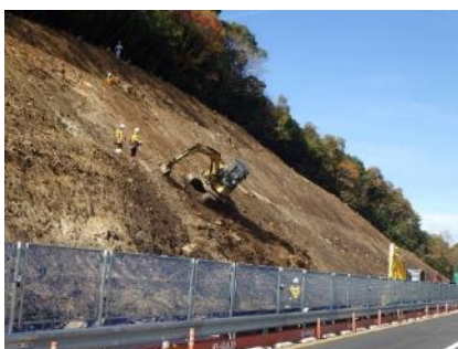
宇佐道路の法面防災工事状況（無人化掘削マシンが活躍中）
