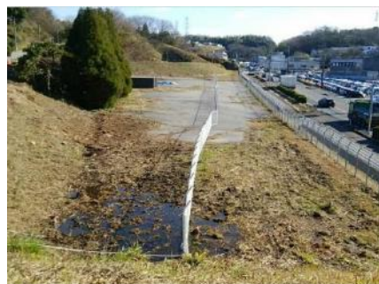
【駕野地区の工事状況】
