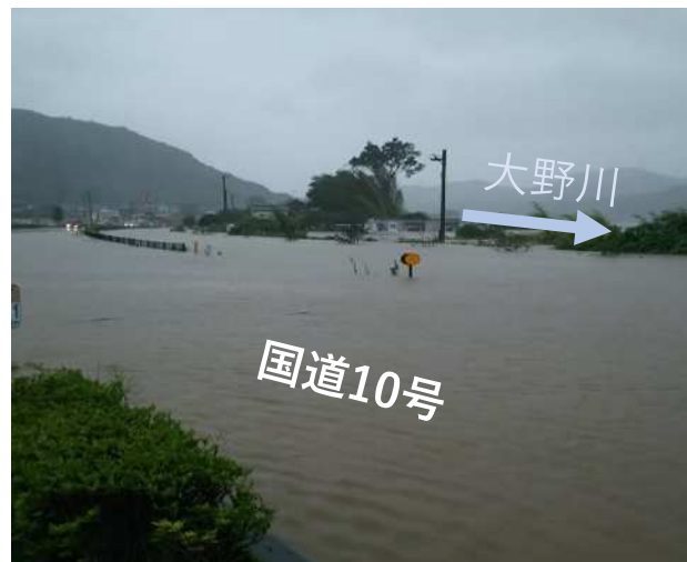
大野川右岸利光地区浸水状況 (H29.9.17)
