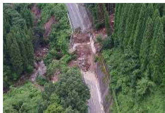
法面崩壊（九重町野上）
