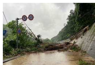
法面崩壊（九重町野上）
