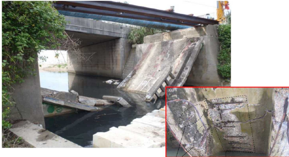
写真 2-1 老朽化が原因で落橋した国内事例
