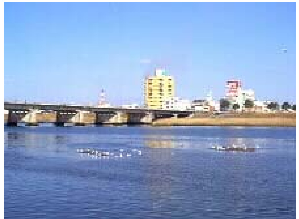
舞鶴橋（国道197号）の写真 53
