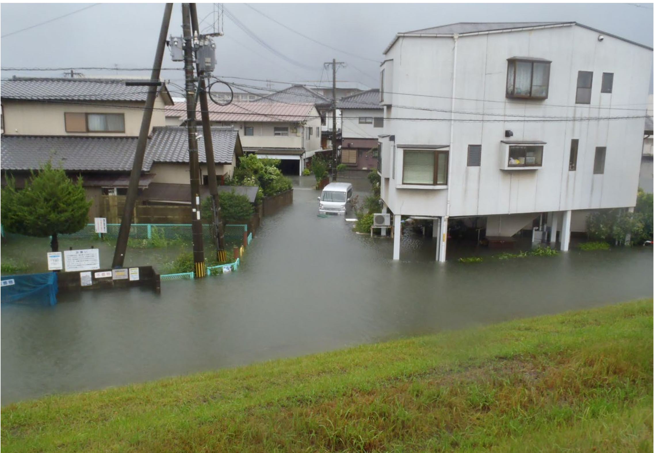
2017年(平成29年)9月洪水(台風18号) 大分川水系七瀬川付近 被害状況
