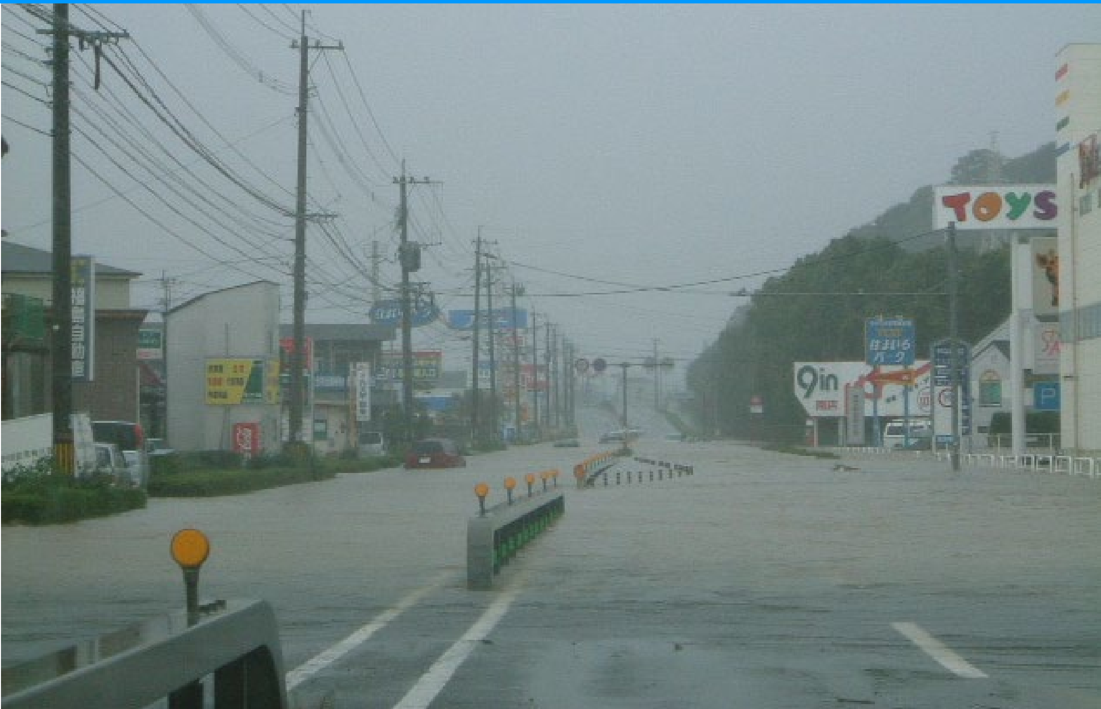
2004年(平成16年)10月洪水(台風23号) 大分川付近 被害状況(内水)
