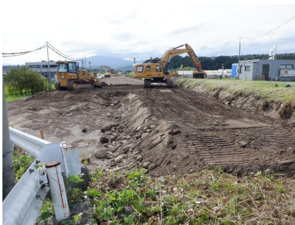
ICT建設機械による河道掘削事例 (国分地区)
