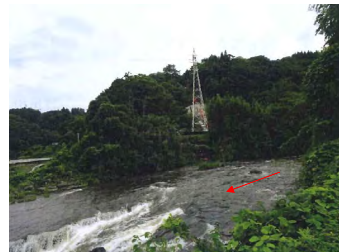
(令和3年4月 完成(稲葉川)竹田土木事務所)
