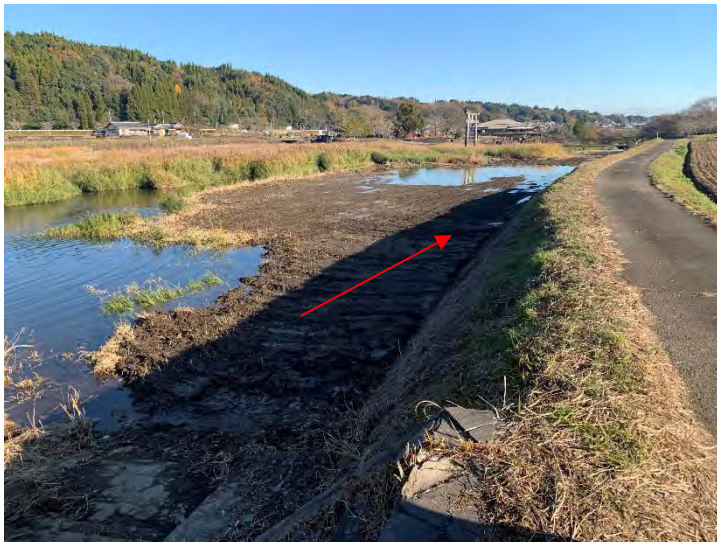
(令和3年12月完成(緒方川)豊後大野土木事務所)
