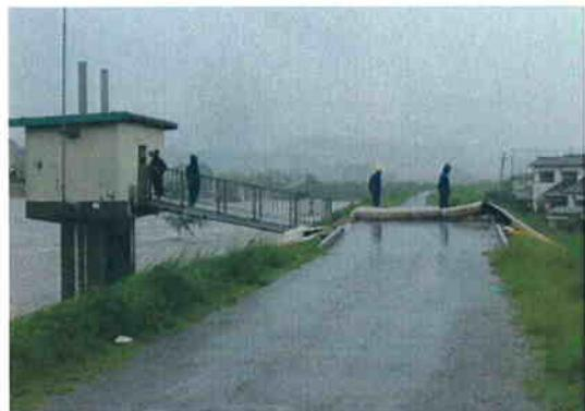
写真 4.3.12 緊急内水対策車による内水排除
