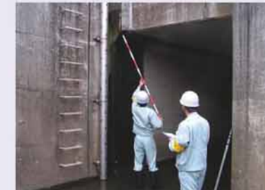
樋門の保守点検状況
