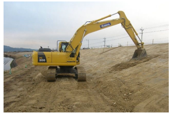
写真 5.3.3 堤防法面補修
