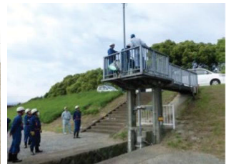
水閘門の現地一斉点検
