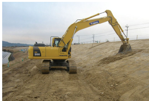
堤防法面補修
