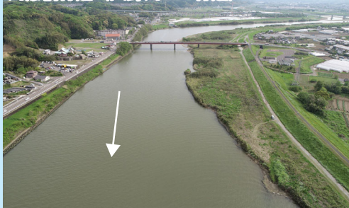
川添橋付近（大野川7k0付近）
