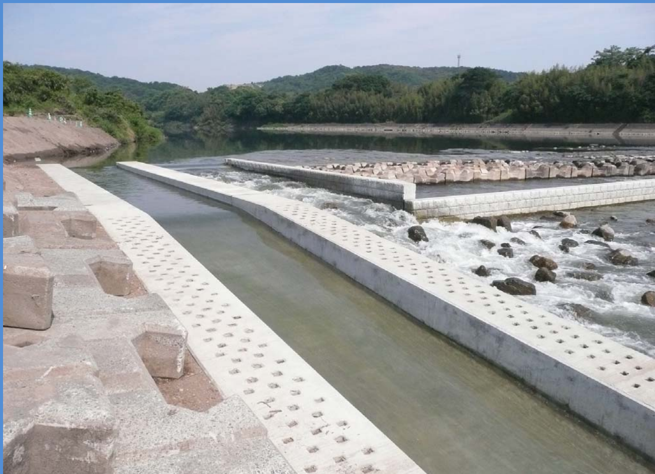
【舟本大橋上流の床固(堰) 関係記事はP4】
