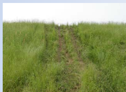
【堤防の斜面を車両で走行した痕跡】
